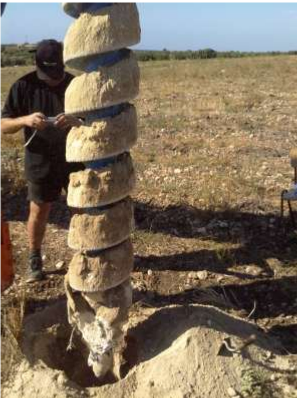
Der Projektleiter von Ideemasun, Herr Thomas Art bei der Kontrolle und Dokumentation der Bohrungen
