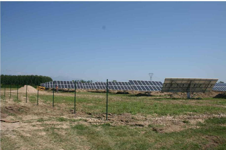
Das Foto wurde am 09.07.2011 von uns aufgenommen. Es zeigt die ersten 1-achsigen Trackersysteme. Die Leistung dieses Teilbereiches des Solarkraftwerkes beträgt ca. 1.930 kWp.
