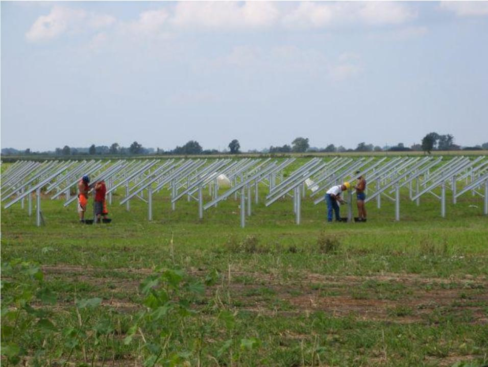
Das Foto zeigt die Bauarbeiten in Palazzolo Stand 17.7.2011. Die Unterkonstruktion ist annähernd fertiggestellt. Als nächster Arbeitsschritt werden ab dem 21.7. die Solarmodule und Wechselrichter montiert. Der Netzanschluss ist von dem Stromversorger ENEL für den 13.8.11 zugesagt. Derzeit verlegt ENEL die Hochspannungskabel zum Grundstück.
